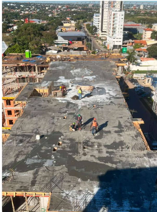
Avance de encofrado losa N8 – Cargamento losa N8 – Cargamento de pilares N8-N9
