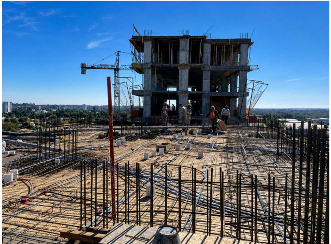
Cargamento de pilares N8 – N9 – Avance de encofrado losa N8
